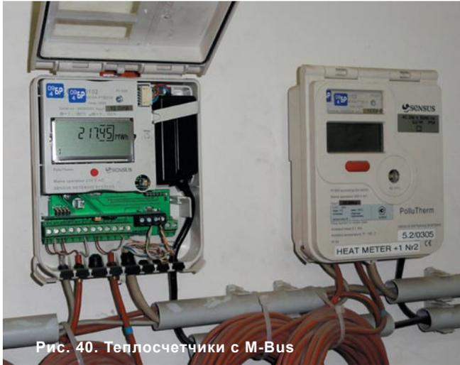
Рис. 40. Теплосчетчики с M-Bus
