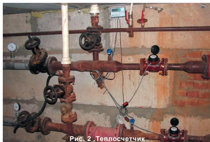
Рис. 2. Теплосчетчик
