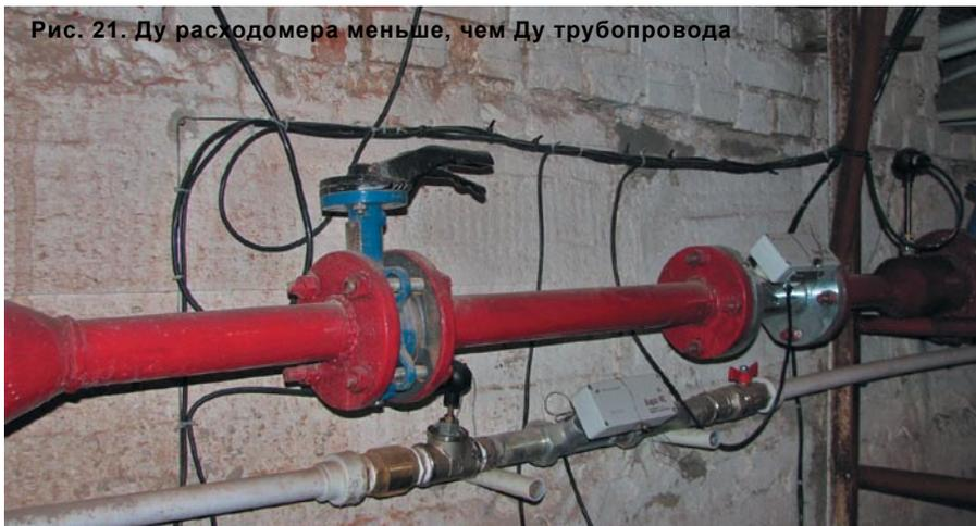
Рис. 21. Ду расходомера меньше, чем Ду трубопровода
