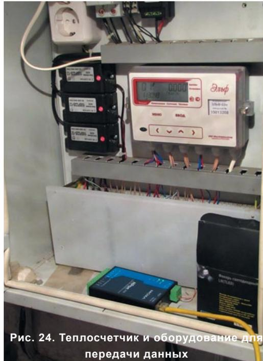
Рис. 24. Теплосчетчик и оборудование для передачи данных
