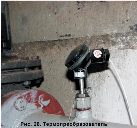
Рис. 28. Термопреобразователь
