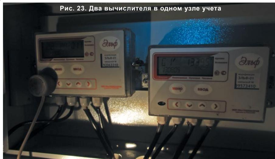
Рис. 23. Два вычислителя в одном узле учета
