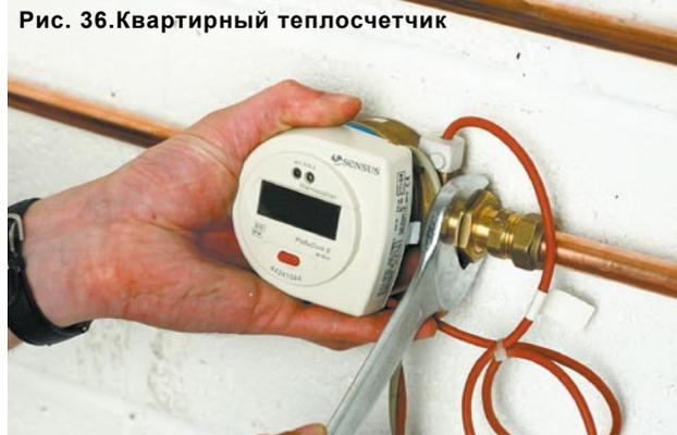
Рис. 36.Квартирный теплосчетчик
