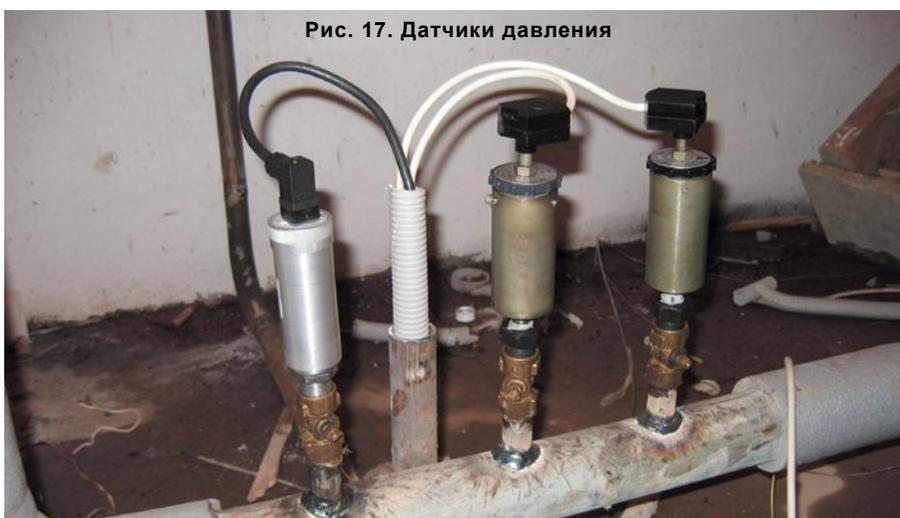
Рис. 17. Датчики давления
