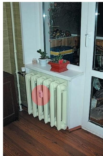
Рис. 2. Радиаторный распределитель INDIV - миниатюрная альтернатива теплосчетчику
