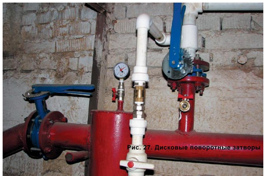
Рис. 27. Дисковые поворотные затворы
