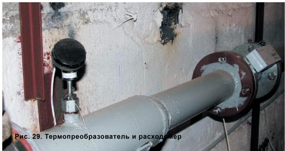
Рис. 29. Термопреобразователь и расходомер
